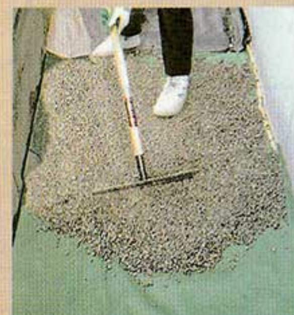
防草シート施工
